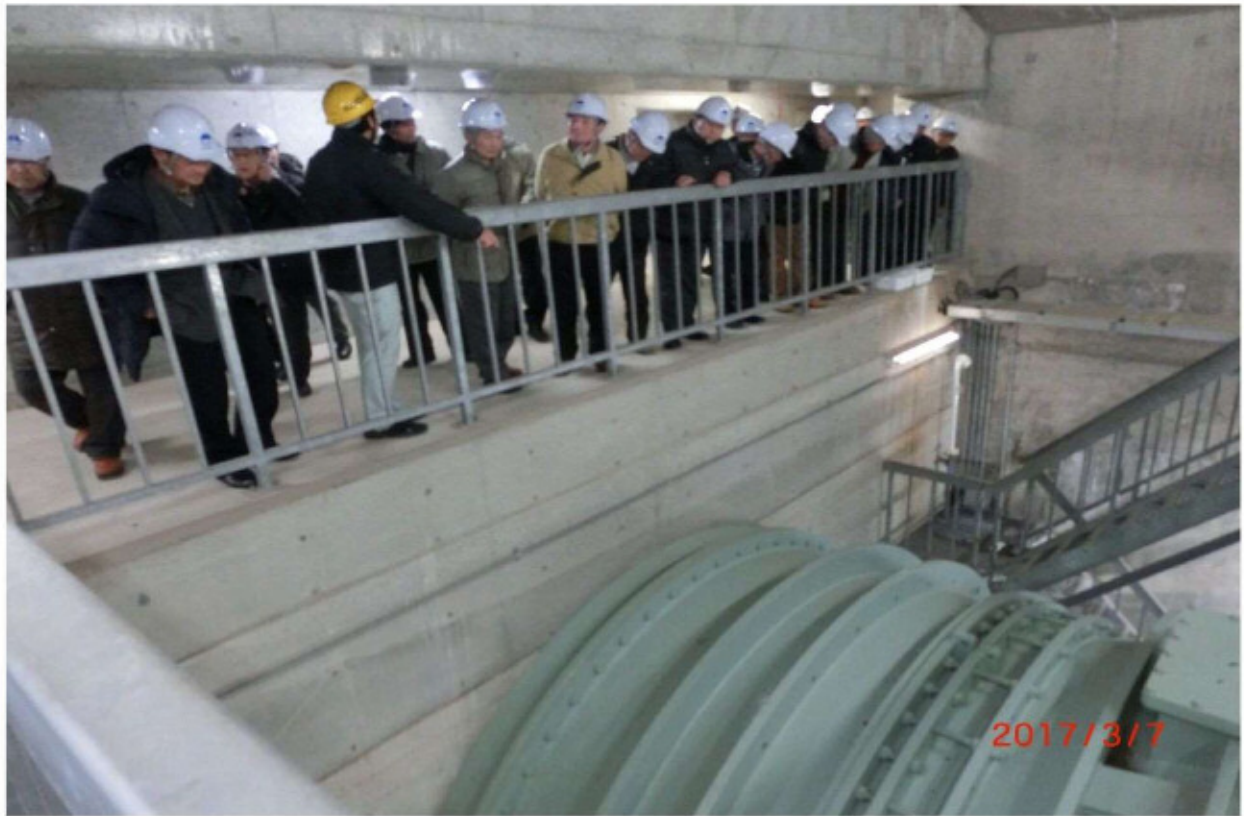
新川河口排水機場のチューブラポンプφ4,200の設置状況
