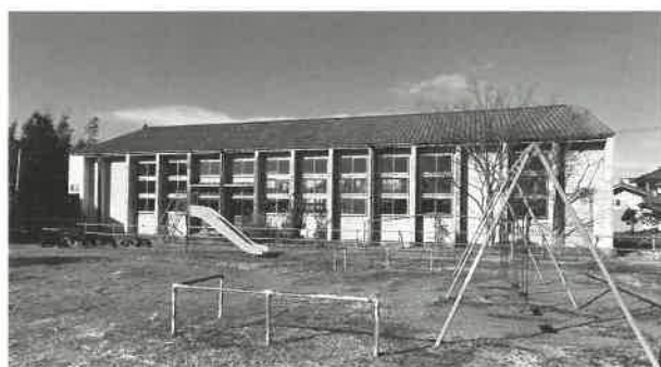
▲解体される旧西公民館
