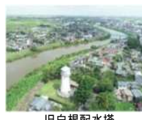
旧白根配水塔
