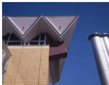
10 新潟美術館 折版屋根と冷暖房設備の煙突 [撮影：関谷正昭]
