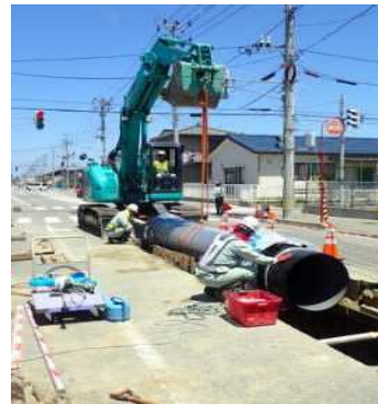
水道管工事の様子
