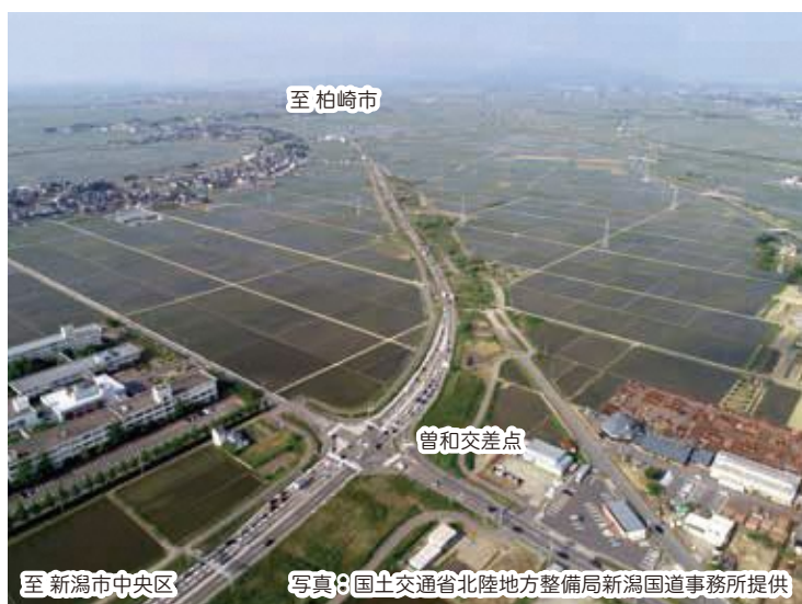
一般国道116号新潟西道路
