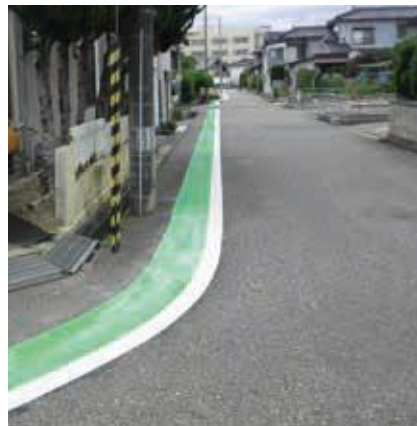
通学路の危険箇所の対策 (グリーンベルト設置)
