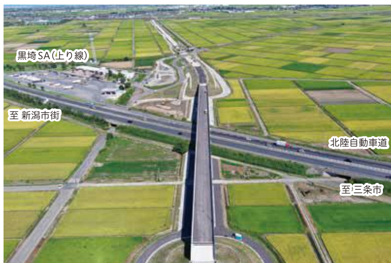
新潟中央環状道路くろさき茶豆大橋
