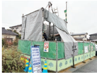
液状化対策のためのボーリング調査
