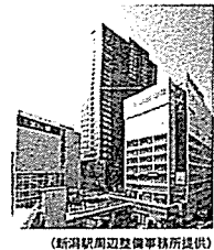
(新潟駅周辺整備事務所提供)
