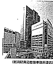
(新潟駅周辺整備事務所提供)
