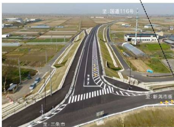
【写真】中ノ口工区(部分供用区間)
