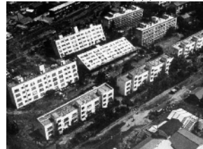
写真 液状化により倒壊した 県営アパート
