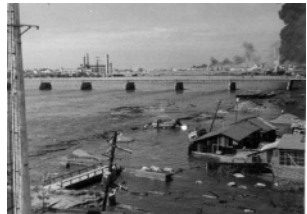
写真 新潟地震により発生した津波
