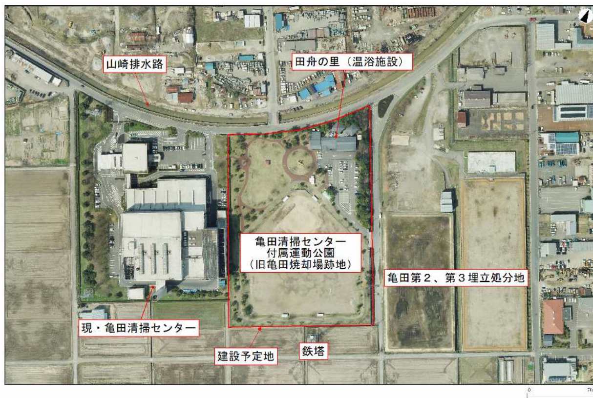
図 4.1.2 建設予定地周辺の状況
