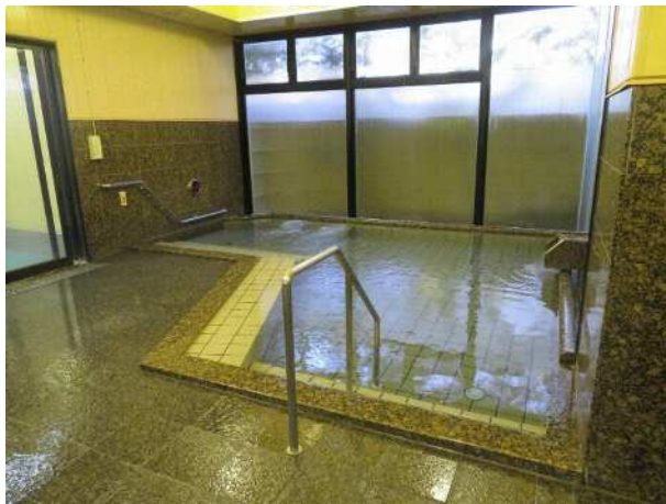
休憩所「田舟の里」の浴室
