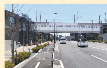
新潟鳥屋野線(中央区水島町付近)
