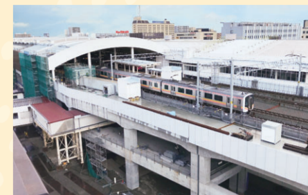
高架駅2番線ホームの西側・白山方面(令和2年11月撮影)
