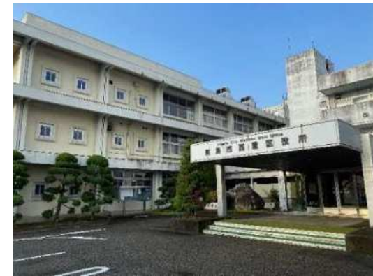
西蒲区役所庁舎外観
