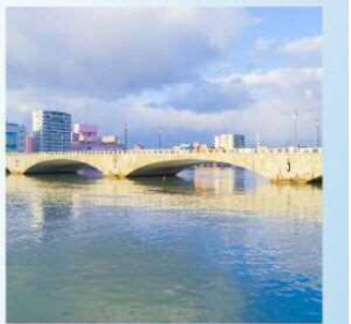
最先端技術で造られた萬代橋
