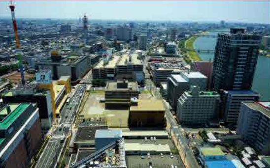
信濃川右岸でひとときわ自立つ「新潟日報メディアシップ」。北前船をイメージした建物は地上20階の高層ビルで、飲食店やホールも併設。展望フロアもあります。
